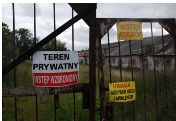
Fot. 2. W powiecie bytowskim część mienia pozostającego po PGR-ach nie została zagospodarowana – budynki czekają na rozbiórkę (fot. AP)
