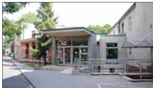
Siedziba Powiatowego Urzędu Pracy w Rudzie Śl.
